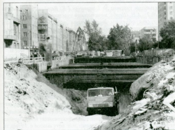
Строительство ст. «Площадь им. Ленина», июль 1982 г.
